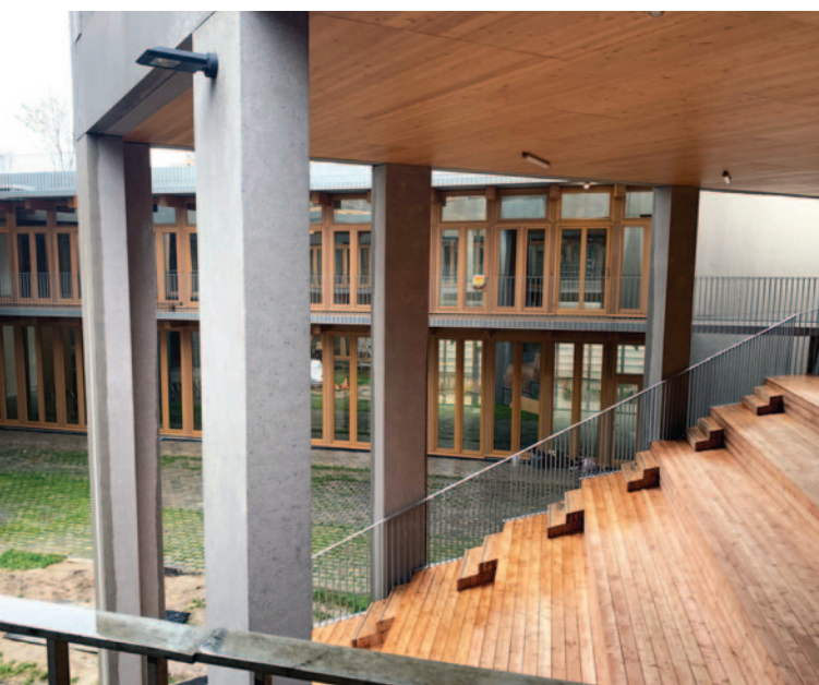
Menuiseries bois de la tour H1 dotées d'un vitrage phonique de 40 dB.
