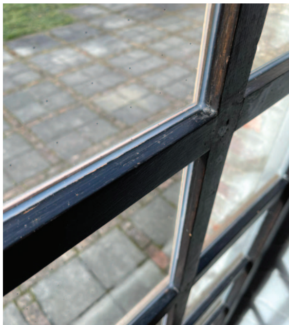
Menuiseries bois dans cette maison en Belgique, dont certaines avec du petit bois, rénovées avec doubles vitrages sous vide Fineo d'AGC Glass par RenoWindow.
