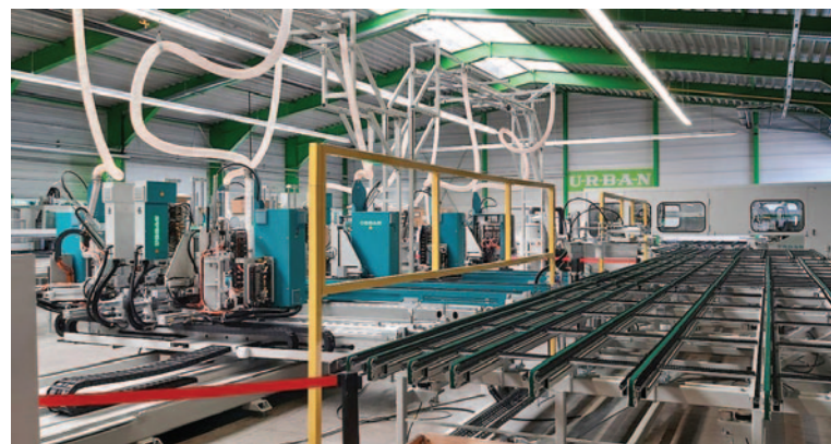
La ligne automatique de soudure-ébavurage des dormants.
