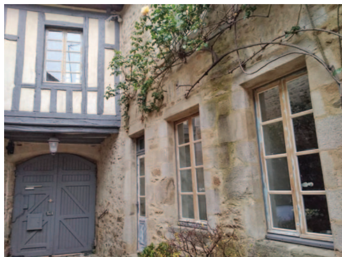
Les menuiseries bois de cette maison à Vannes ont été rénovées avec des doubles vitrages sous vide Fineo d'AGC Glass par l'entreprise nantaise DV Renov.
