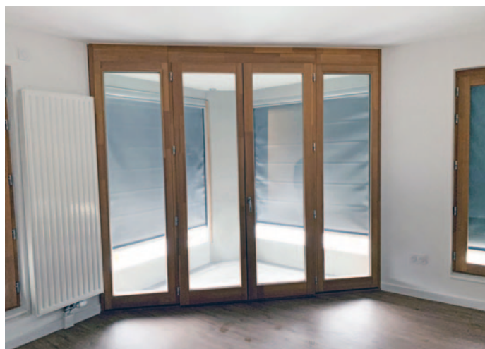
Porte-fenêtre avec stores extérieurs manœuvrés électriquement avec un guidage par coulisse pour une occultation totale. La toile est notamment dotée d'une couche bitumeuse pour une opacité maximale.
