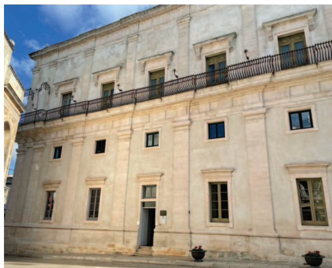
Rénovation avec double vitrages sous vide Pilkington Spacia des parties vitrées des salles de la mezzanine du Palazzo Ducale à Martina Franca (Italie) en préservant les cadres historiques des fenêtres.
