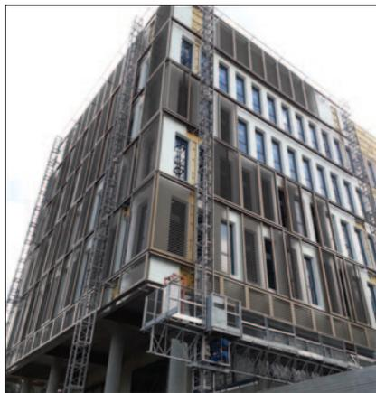
telles et de volets. Ce sont ainsi 1 100 volets fixes et coulissants, avec quelques 35 dimensions différentes en fonction des étages et de l'exposition des façades, qui ont été mis en œuvre par l'entreprise de pose Isore Bâtiment à l'aide de plateformes mobiles.
