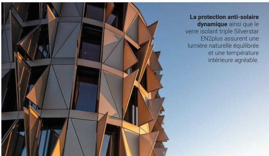
**La protection anti-solaire dynamique** ainsi que le verre isolant triple Silverstar EN2plus assurent une lumière naturelle équilibrée et une température intérieure agréable.
