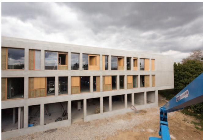
Parties pleines des ouvrants en mélèze et parties vitrées intégrées au béton.
