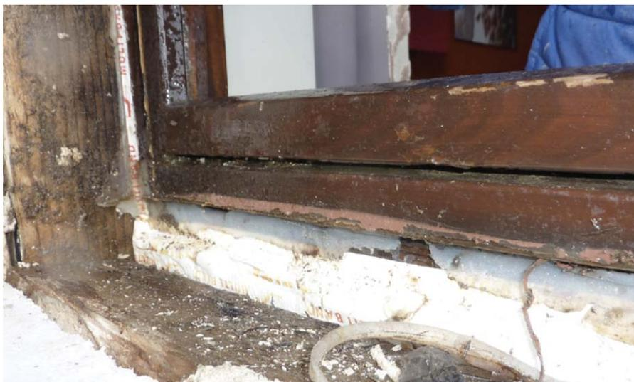
Effets de la rétention d'eau sous l'isolant en technique d'ITE
