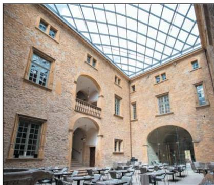
**Verrière surélevée en acier** avec ossature métallique et vitrages uniques en losanges pour le château de Bagnols (69)
