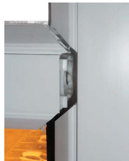
Rupture d'un assemblage mécanique en menuiserie PVC
