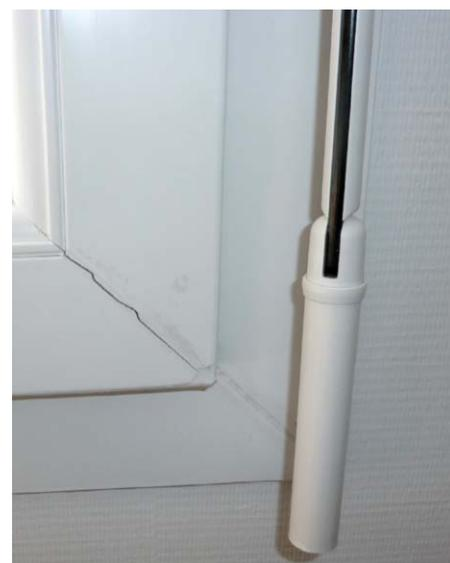
Rupture de soudure d'un angle de cadre PVC
