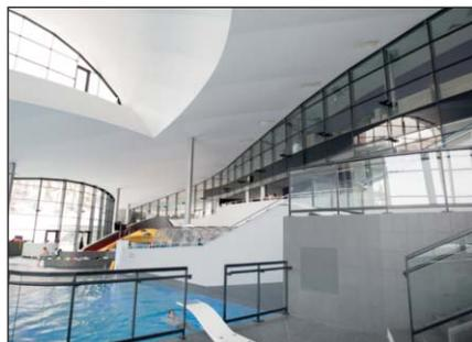
**Murs rideaux intérieurs** grande hauteur en aluminium avec biais sous plafond et vitrages cintrés, portes acier coupe-feu et garde-corps vitrés pour l'Aquamotion de Courchevel (73)
