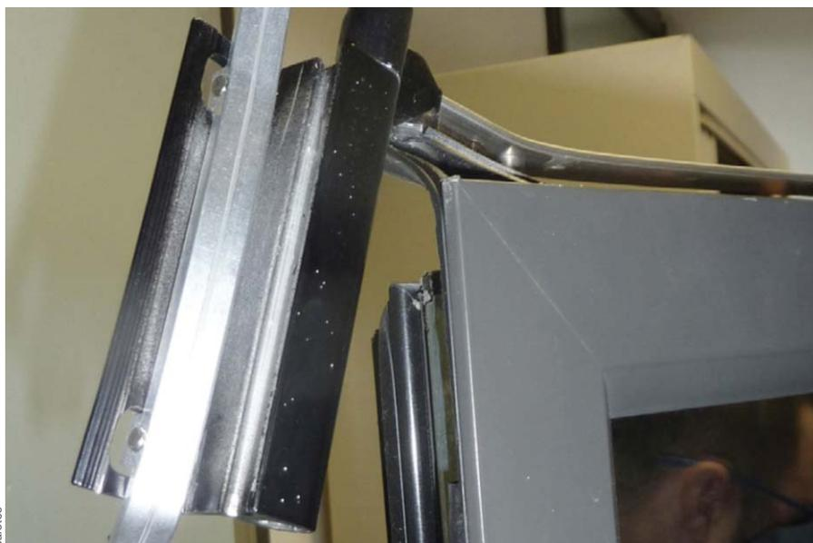
Arrachement de paumelle haute de châssis oscillo-battant
