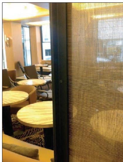
L'intégration du tissu dans le vitrage feuilleté est réalisée en autoclave sous une pression de 15 bar et à une température de 150 °C
