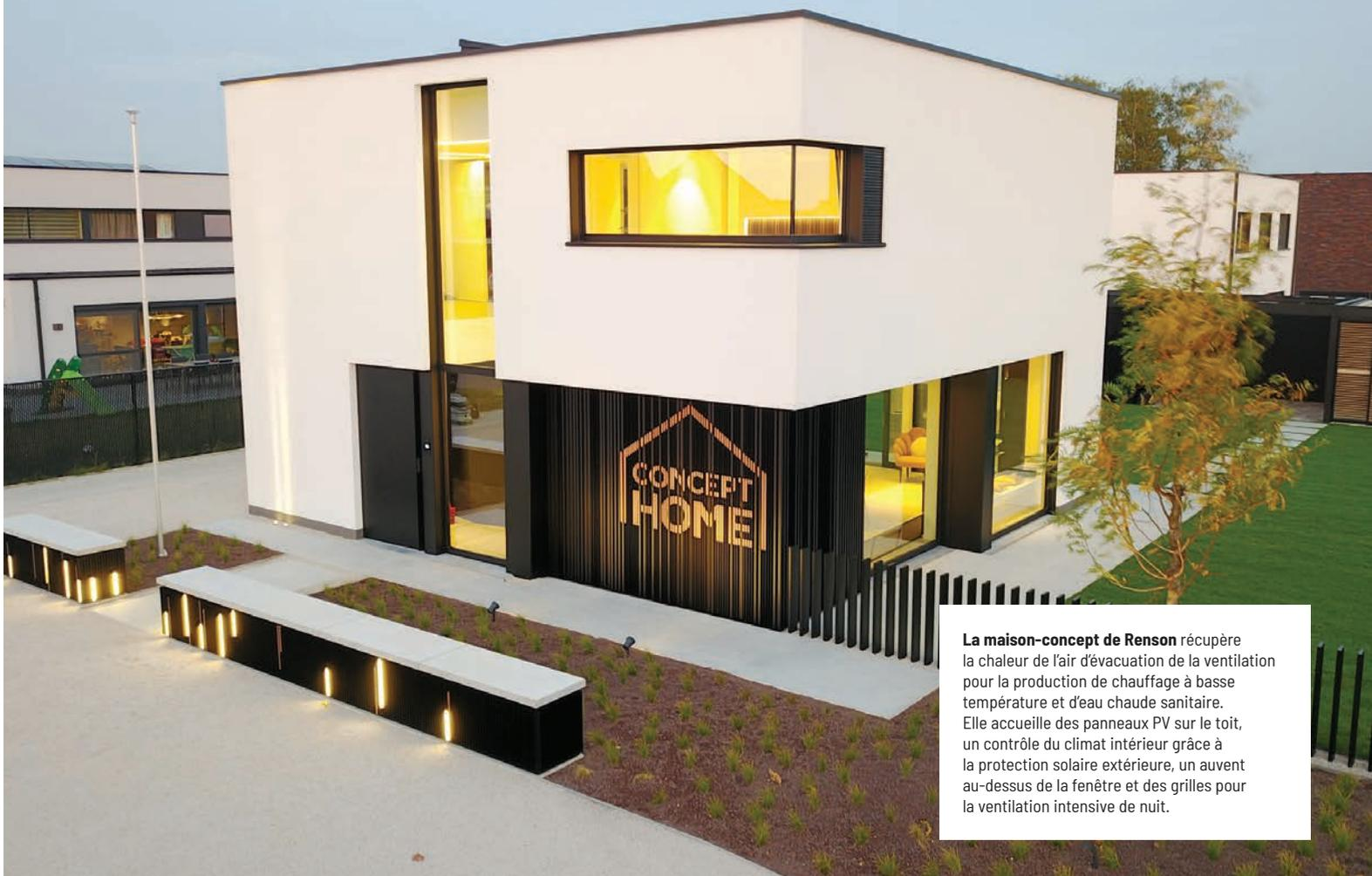
**La maison-concept de Renson** récupère la chaleur de l'air d'évacuation de la ventilation pour la production de chauffage à basse température et d'eau chaude sanitaire. Elle accueille des panneaux PV sur le toit, un contrôle du climat intérieur grâce à la protection solaire extérieure, un auvent au-dessus de la fenêtre et des grilles pour la ventilation intensive de nuit.
