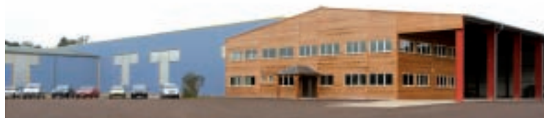
L'usine de thermolaquage des profilés aluminium SLA à Fougerolles (71)
