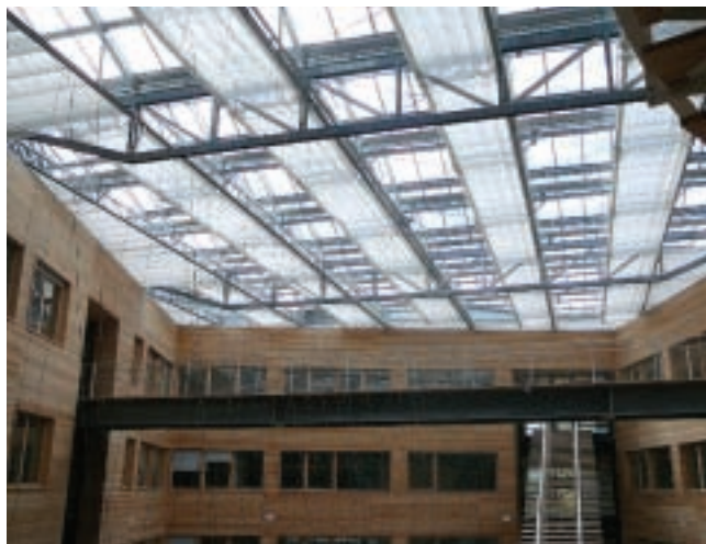
La verrière et ses vélums de protection solaire.
