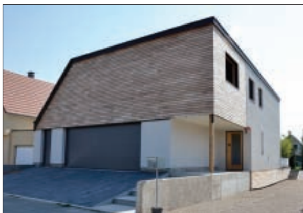
L'angle nord-ouest de la maison
