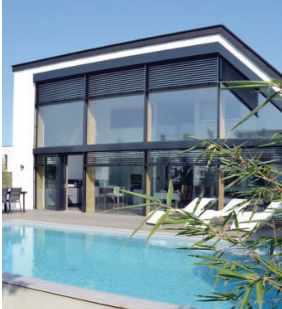
La façade sud, entièrement protégée par ses brise-soleil
