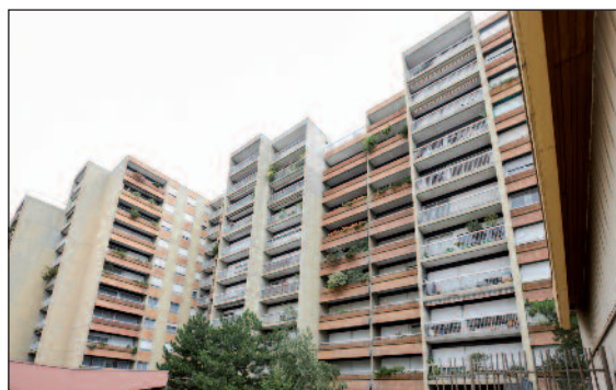
Chantier fini avec les nouveaux couissants.
