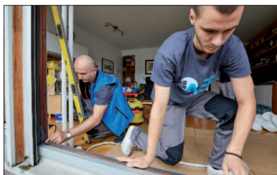
Mise en place de l'étanchéité des nouveaux dormants.
