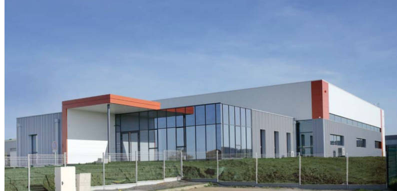
Les nouveaux locaux bénéficient d'une bonne visibilité et d'un accès direct à l'autoroute A87.
