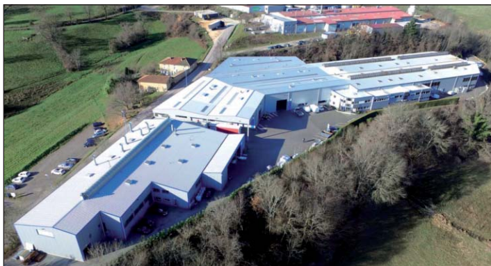
Vue aérienne de l'usine à Cours-la-Ville (69)
