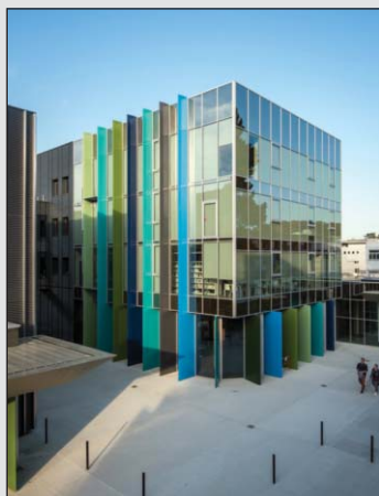
Restructuration du Campus du Tertre à Nantes (44) – Bouygues Bâtiment Grand Ouest.
