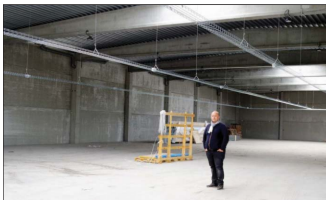
Ce bâtiment a une surface de 1 600 m 2
