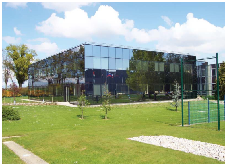
Un bâtiment de 5 000 m 2 va être construit à Congrier.
