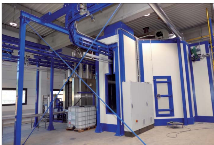
Une chaîne de laquage vient compléter l'outil de production et vient d'être mise en fonctionnement ce mois de juillet.
