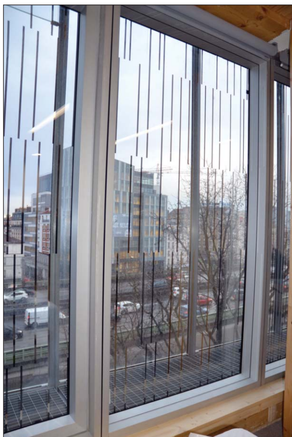
La double façade côté nord, avec sa légère inclinaison (à droite).
