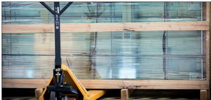
Les caisses sont facilement déplaçables sur le chantier grâce à un transpalette.
