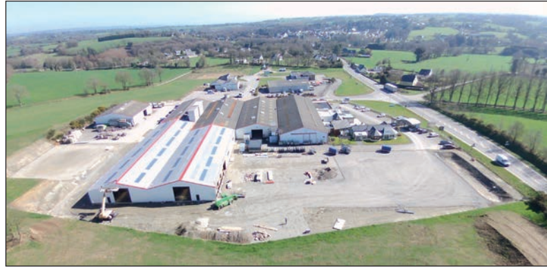
Vue aérienne de l'usine, avec l'extension au premier plan.
