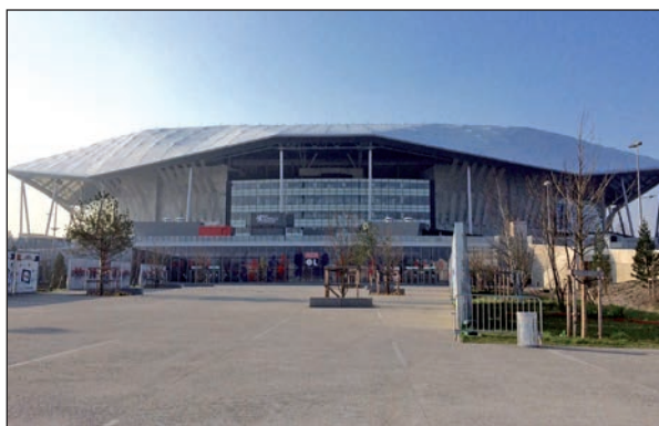
Le Parc OL, un chantier emblématique pour Installux
