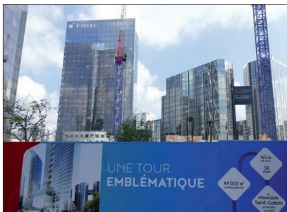
L'emplacement du chantier.
